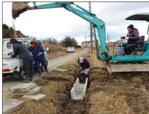
地元活動組織による農業排水路の設置
